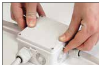
4.- Polimerización Dejar en reposo durante aproximadamente 10 minutos para alcanzar la polimerización adecuada del compuesto y taponar la caja.
